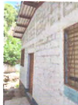
REPARACIÓN DE REPELLO Y CERNIDO EN PAREDES
