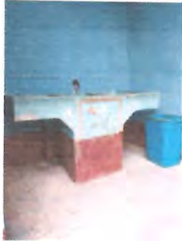
REPARACIÓN O SUSTITUCIÓN DE ÁREA DE COCINA SUSTITUCIÓN DE PILA DE CONCRETO 2 LAVADEROS POR FILTRACIONES
